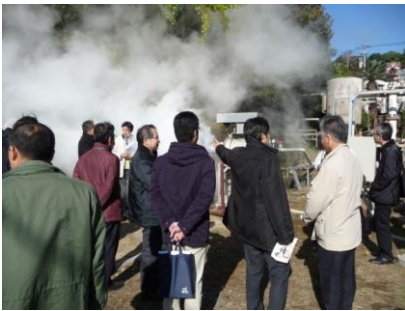
湯けむり発電実証施設 (別府市)
