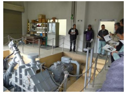
小水力発電所 (豊後大野市)
